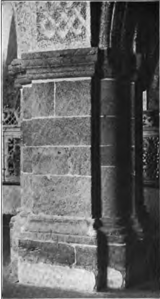
Fig. 176. Walderbach. Pfeiler auf der Westempore der Klosterkirche.
